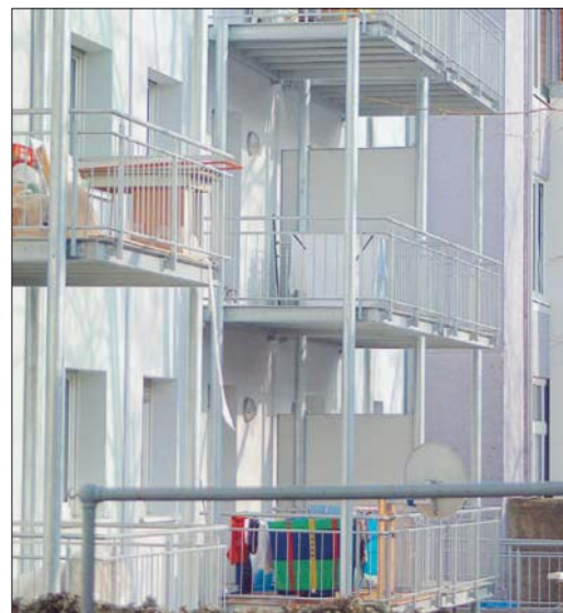
Neue Aussichten: die von der GVV in der August-Ruf-Straße sanierten Wohnungen verfügen jetzt über Balkone.
