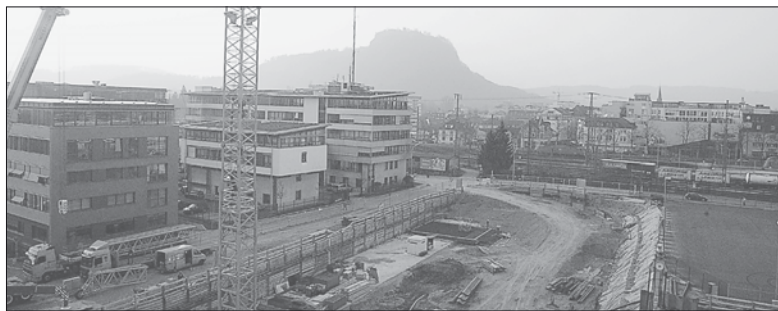
Ein Bild aus Baustellenzeiten: alleine die bis zu 3 Meter dicke Bodenplatte verschlang 4.500 Kubikmeter Beton um das Gebäude auf ein sicheres Fundament zu stellen. Insgesamt wurden im Hegau-Tower rund 15.000 Kubikmeter Beton und 3.000 Tonnen Stahl verbaut. swb-Bild: of
