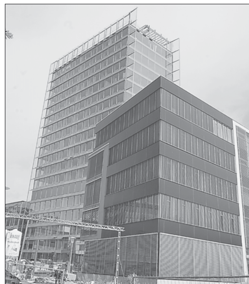
Das Sintec befindet sich derzeit im Umbruch. Hier sind in letzter Zeit viele Flächen frei geworden. Weil es derzeit wenige Anfragen von Existenzgründern gibt, wird überlegt die Flächen anderweitig zu nutzen, um der Nachfrage im Umfeld des Hegau-Towers gerecht zu werden.
