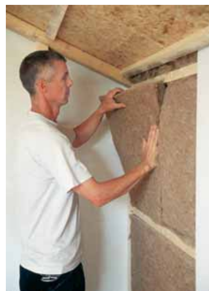
Mit der Dämmung der Außenwand wird die Schimmelgefahr beseitigt.
