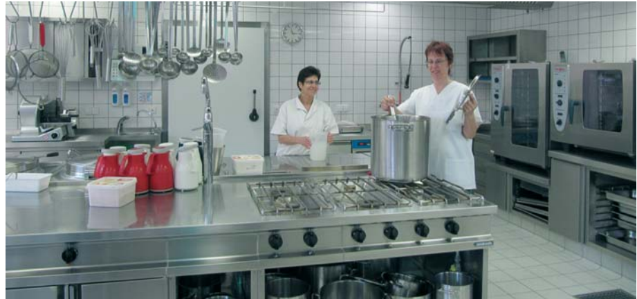
Die neu sanierte Großküche im Altenpflegeheim St. Hildegard bietet beste Voraussetzung für gute Versorgung der Bewohner.
