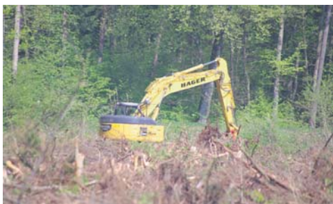
Derzeit finden noch Rodungsarbeiten für die neue Mittelspange Ost statt. swb-Bild: of
