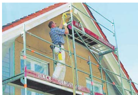
Energie sparen außen und innen: Neue Heizung und dämmen.
