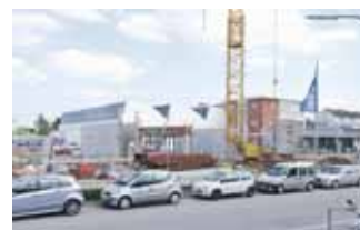
Vor wenigen Wochen haben am VW-Zentrum Singen die Bauarbeiten für den Neubau des Werkstattgebäudes begonnen. Bis zum Oktober soll die Inbetriebnahme erfolgen.
