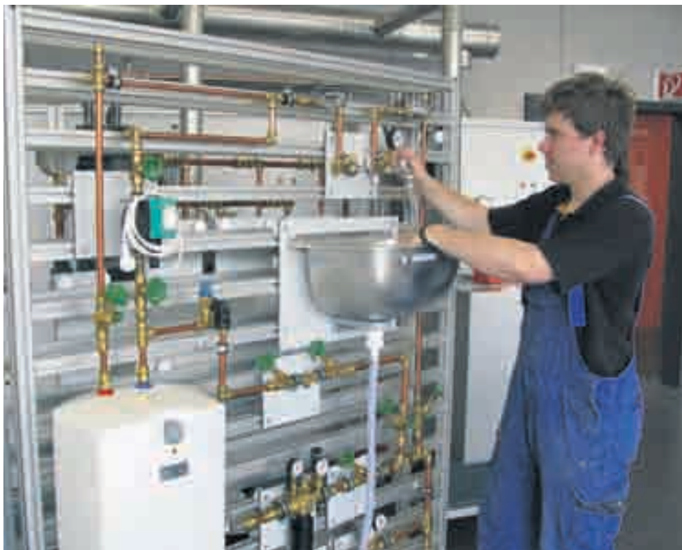
Die Prüfungsaufgaben für die Gesellenprüfung verdeutlichen die hohen Ansprüche, die das Sanitär-, Heizungs- und Klimahandwerk inzwischen an die Auszubildenden stellt. Die Berufsbezeichnung Anlagenmechaniker trägt dem Rechnung.
