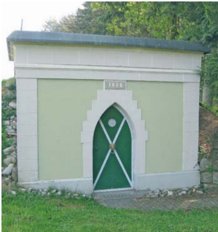
Architektur pur: Der frühere Hochbehälter in Friedingen aus dem Jahr 1906. Jetzt umgebaut zur Wasseraufbereitung.
