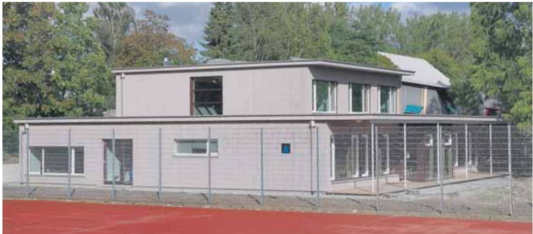
Ein beeindruckender Holzbau ist mit der Erweiterung der Kindertagesstätte an der Singener Masurenstraße gelungen. Anfang September konnte der Betrieb für die zwei Kleinkindgruppen aufgenommen werden, die Außenanlagen werden in den nächsten Wochen fertig gestellt.
