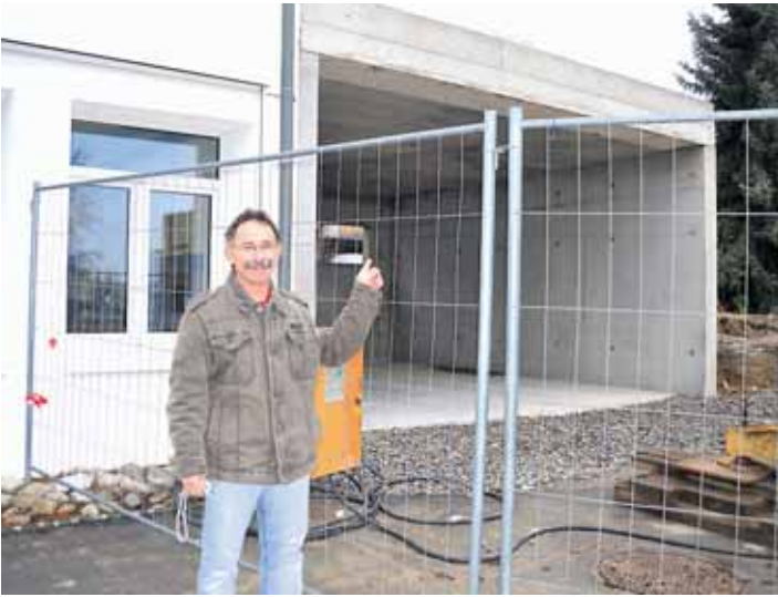
Hier wird die neue Heimat des »FluFaSims« gebaut: Lehrer Jürgen Koch freut sich auf die Fertigstellung der Werkstatteverweiterung.
