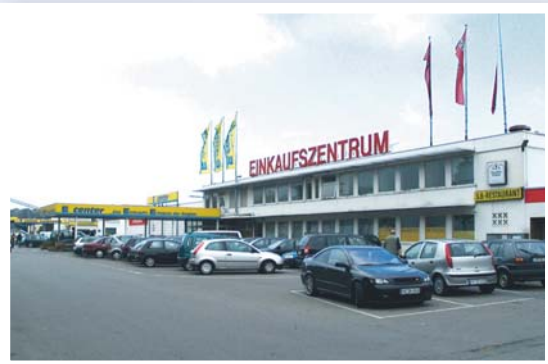
Für die Edeka Südwest ist das E center in Singen mit über 5.000 Quadratmetern Verkaufsfläche einer der größten Märkte. Swb-Bild: of/Archiv
