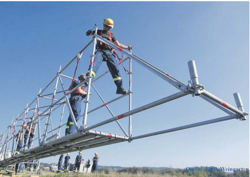
Der THW baut bei Toyota Bach ein sogenanntes EGS Einsatzgerüst auf - eine lange Behelfsbrücke, die begehrbar ist.
