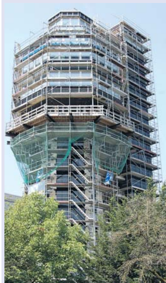
Voraussichtlich im Frühjahr 2016 soll der »aquaTurm« samt Design- hotel der Familie Räßle in Radolfzell eröffnet werden. 20 Zimmer sollen dann in dem »Null-Energie-Haus« untergebracht sein. swb-Bild: gü
