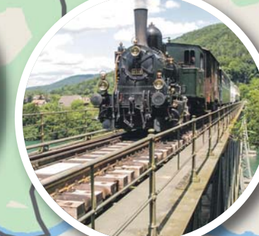
Brücke Hemishofen Die zweitälteste Eisenbrücke der Schweiz bei Hemishofen.
