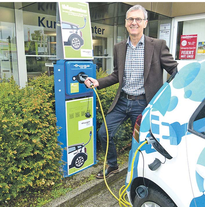
Karl Mohr neben der E-Ladesäule beim Verwaltungsgebäude der Thüga Energie. swb-Bild: Thüga
