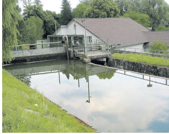
Große Rechen, wie hier beim Aacher E-Werk II, verhindern, dass die Turbinen von irgendwelchem Treibgut beschädigt werden.
