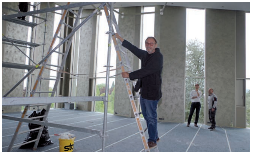
Hermann Maier ganz oben in der »Skylounge« im 5. Geschoss im Finale der Bauarbeiten. Das hier angewandte Lichtkonzept mit Farbspielen an der Decke wird sichtbar nach außen strahlen. Im Hintergrund Architekt Daniel Binder. swb-Bild: of
