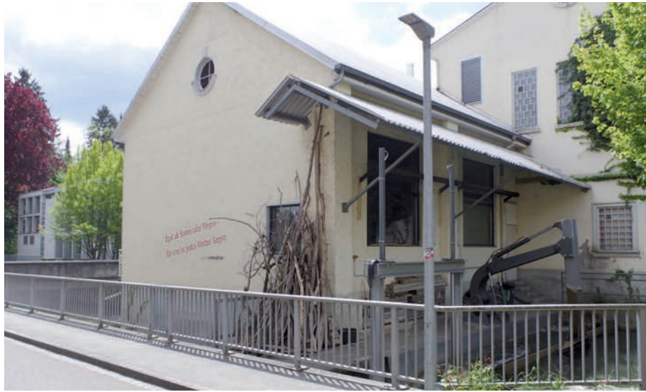
Das Wasserkraftwerk an der Musikinsel in Singen war einst die Wiege des »Gas- und E-Werk Singen« aus dem später die »Tüga Energie« wurde. 1970 stillgelegt, produziert es seit 2004 durch Bürgerengagement wieder sauberen Strom. swb-Bild: of
