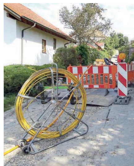
Glasfaserkabel werden eingezo-gen.
