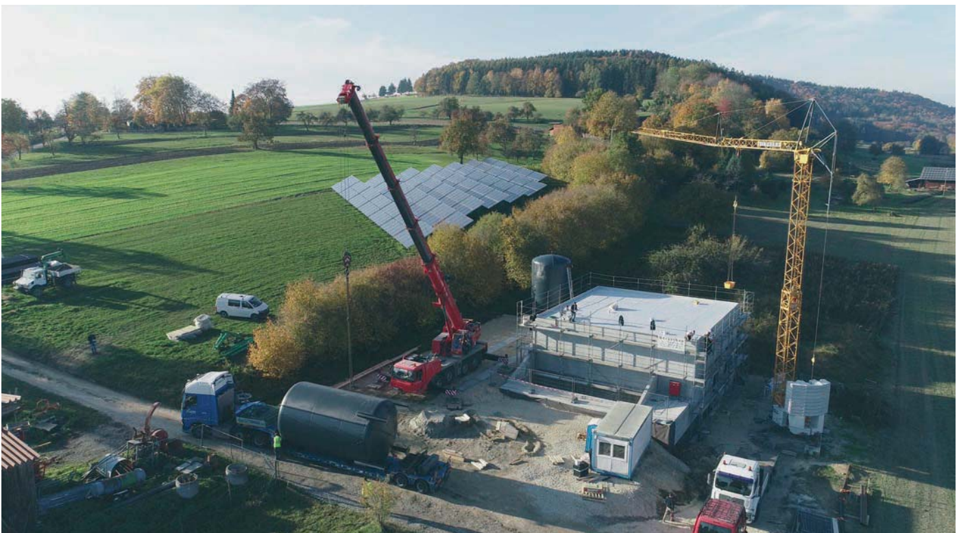
Anlieferung der Pufferspeicher für das Nahwärmenetz.
