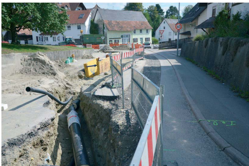
Der Tiefbau für die Trassen begann bei der Pfarrer-Braun-Straße und Am Rimmelsberg, gefolgt von der Litzelhardthalle und Im Seelenhofer. Die Bodanrückstraße und Dettelbachstraße bis zur Heizzentrale folgten im September. Im Februar 2019 wurden die Trassen im Abschnitt In der Schwärze verlegt.
