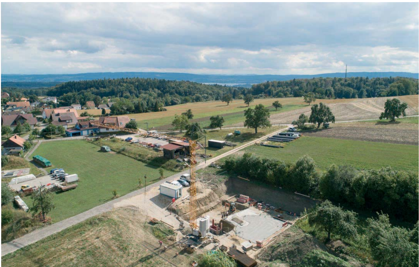
Mitte Juli 2018 wurde das Fundament für die Heizzentrale betoniert.
