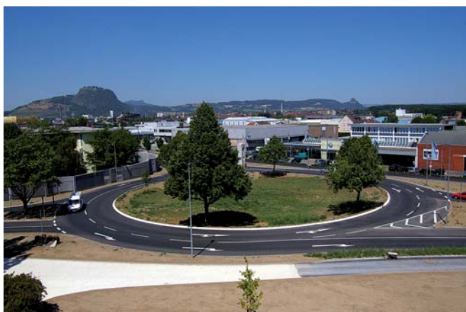
Der Kreisverkehr zur Steißlinger Straße wurde zu Erhöhung der Leistungsfähigkeit im Jahr 2006 umgebaut. Das Bild entstand unmittelbar vor der Einweihung. swb-Bild: of
