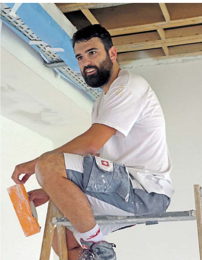
Florian Hirt beim Arbeitseinsatz im Berufsschulzentrum Stockach, das während der Sommerferien in vielen Räumen erneuert wurde. swb-Bild: of
