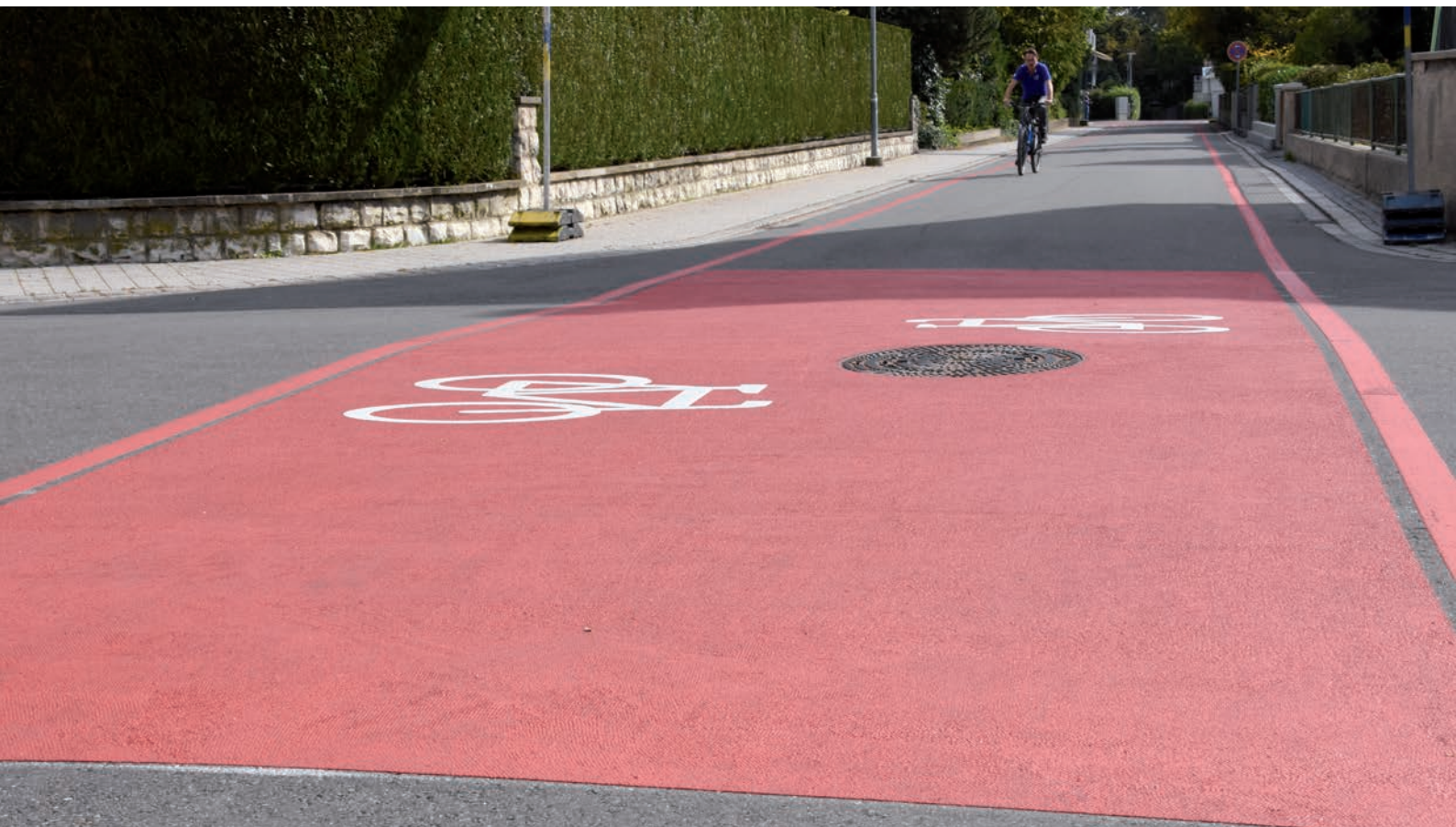
Die neue Fahrradstraße – hier der Teilbereich an der Schillerstraße. swb-Bild: stm
