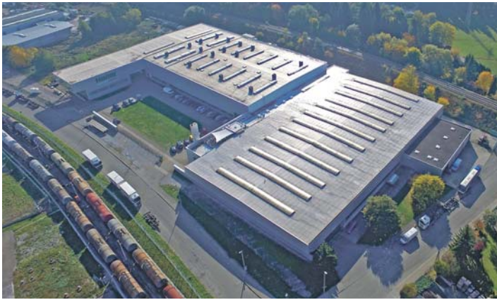
Werk I: Stahlbau
