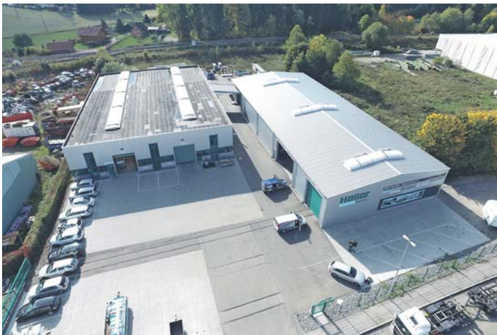
Werk II: Metallleichtbau
