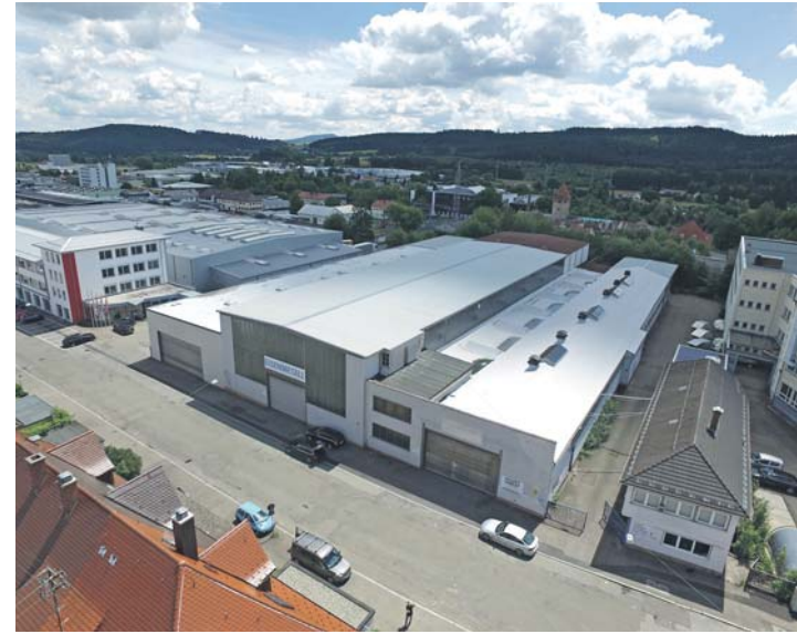
Werk III: Dachtechnik
