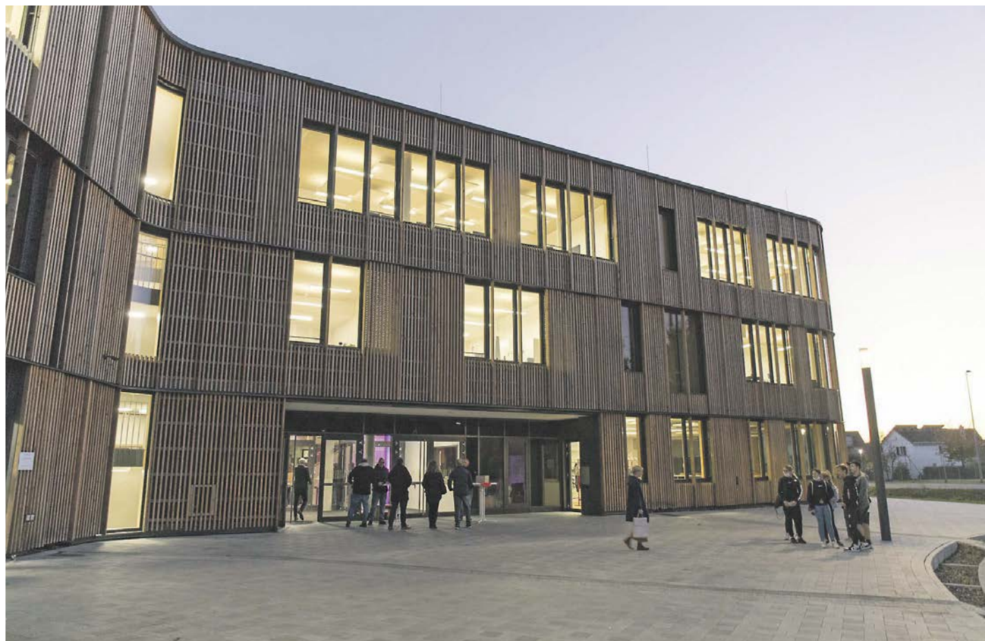
Ein Leuchtturm für die Bildung: der Neubau der Eichendorff-Realschule in Gottmadingen.
