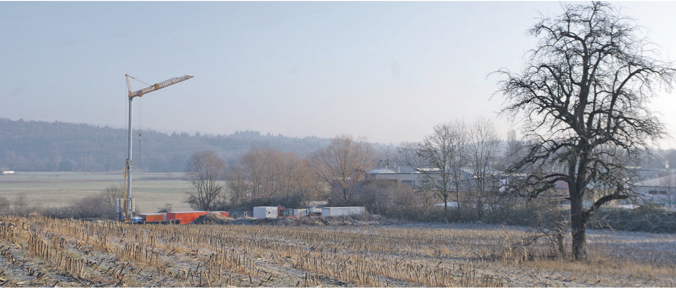
Derzeit laufen die Erschließungsarbeiten und der Aufbau der Agrothermie-Struktur für das künftige »Blurado« in der Fortsetzung des Gewerbegebiets Nord am ehemaligen Radolfzeller Kasernengelände.
