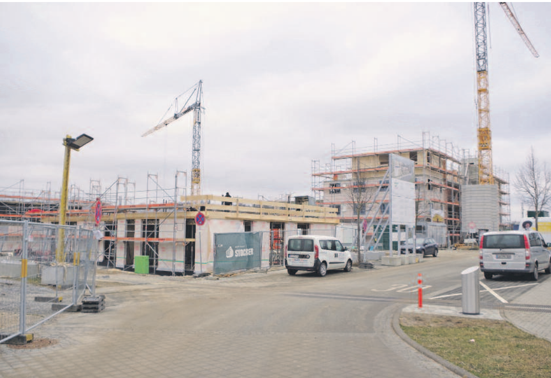
In der Radolfzeller Norstadt wird im Quartier »Bei der alten Eiche« durch die »WiGe Bau GbR« derzeit kräftig gebaut – mit viel Holz übrigens. Dort entstehen mit dem aus dem Verein »Wohnen in Radolfzell« gewachsenen Projekt »WiGe« (für »Wohnen in Gemeinschaft«) 57 barrierefreie Wohnungen im preisgedämpften Standard. swb-Bild: of
